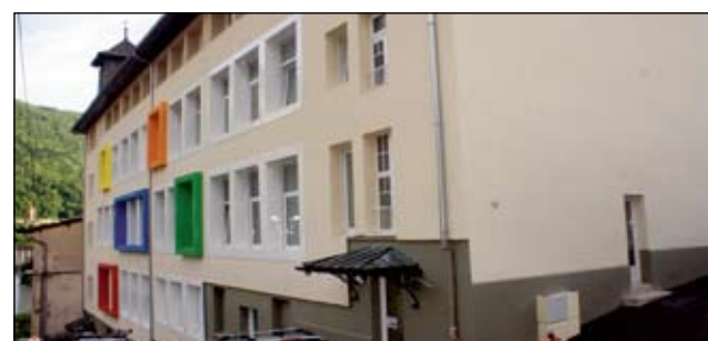
Immeuble Bonneville : création d'une copropriété avec l'OPH qui loue des locaux à l'APEI, une autre partie des locaux appartenant à la communauté de communes est affectée à des salles à la Mission Locale Sud Jura et FRATE (organisme de formation); livré en juin 2012 (650 000 €)
