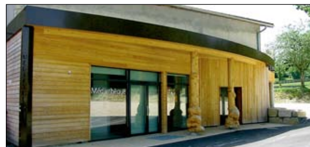
Antenne de la médiathèque de Viry : 460 000 € : livrée en février 2012
