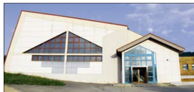
Rénovation du gymnase du plateau du Lizon : o 2012 : mise aux normes handicapés / accessibilité o 2013 : rénovation des espaces de sports et travaux d'économies d'énergie
